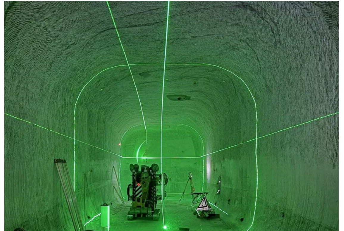
Einbau der Instrumentierung
