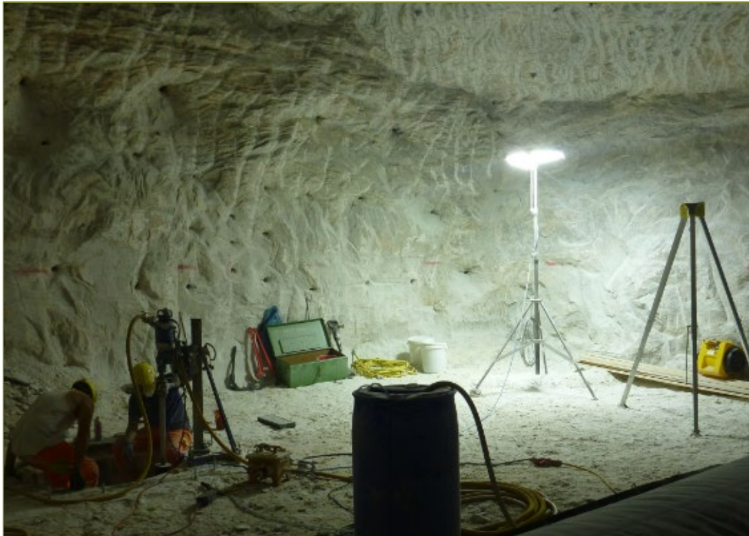
Herstellung des Großbohrlochs
