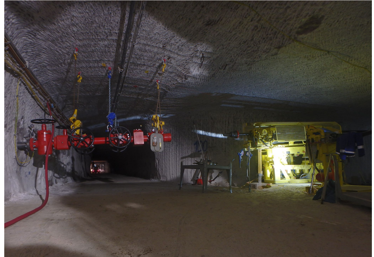
Standrohr und Erkundungsbohrmaschine im Bohrort
