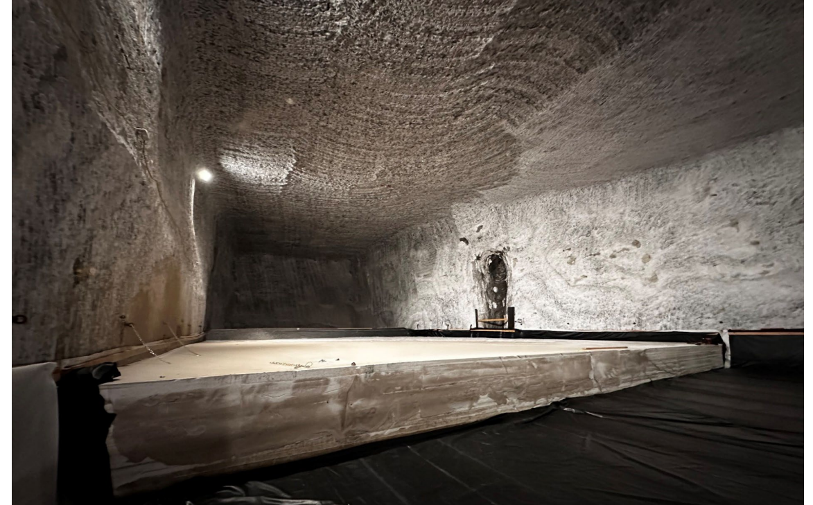
Verfüllarbeiten Probetrieb 1 in das Becken im Abbau 1s auf der 3. Sohle, Umsetzen der Schalung für den Probetrieb 2 – 400 m 3
