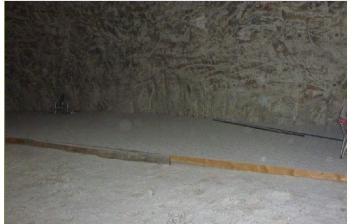
Pflasterarbeiten / Betonage der Nische für Druckregelanlage
