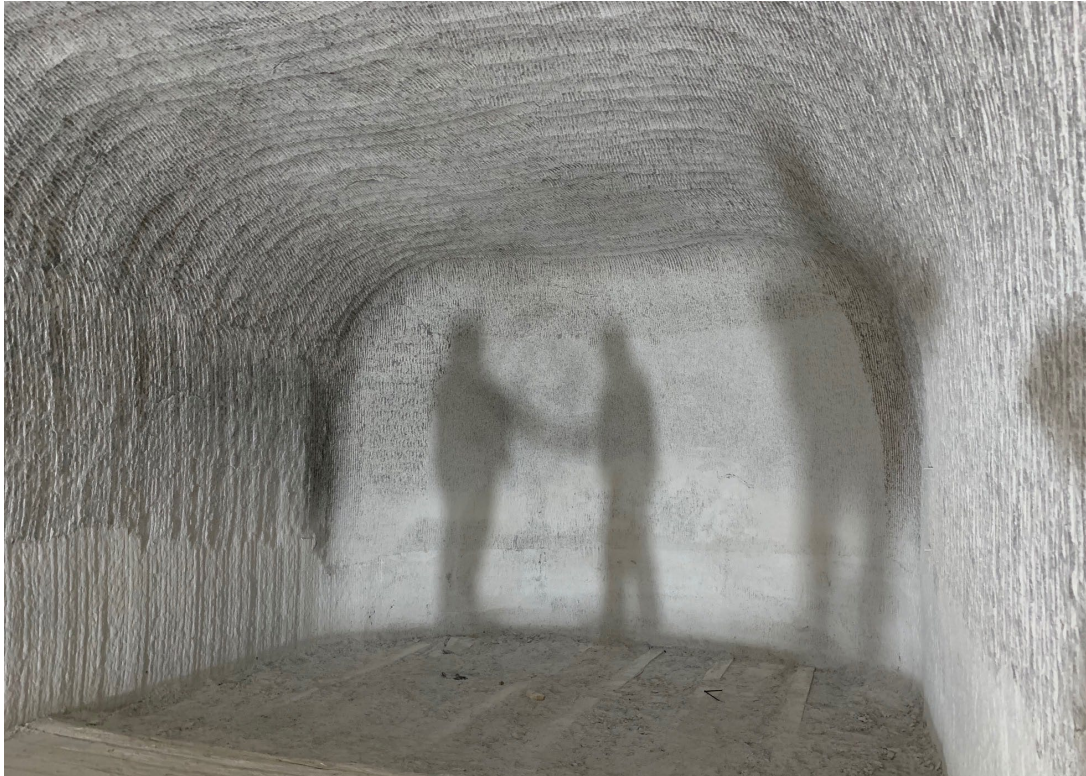
Profil-Schneidarbeiten sind abgeschlossen
